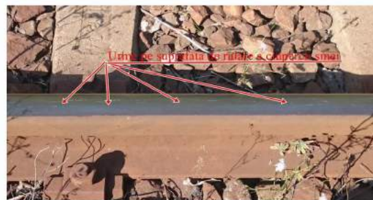
Foto 4. Urme pe suprafața de rulare a ciupercii șinei
